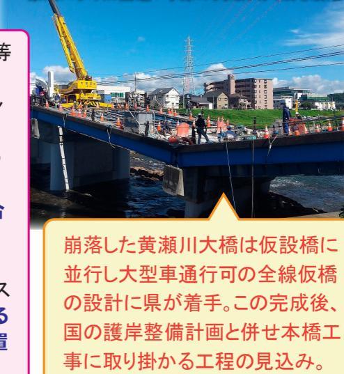
崩落した黄瀬川大橋は仮設橋に並行し大型車通行可の全線仮橋の設計に県が着手。この完成後、国の護岸整備計画と併せ本橋工事に取り掛かる工程の見込み。
